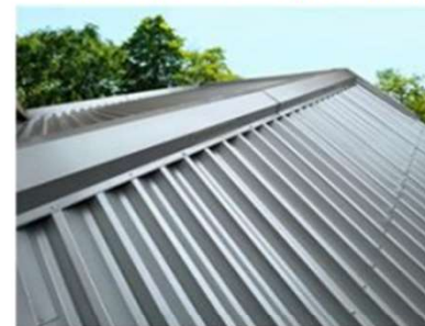
<屋根遮熱工事>
